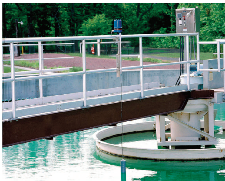
Aplicação de medição de manta de lodo/clareza com tecnologia ultrassônica
