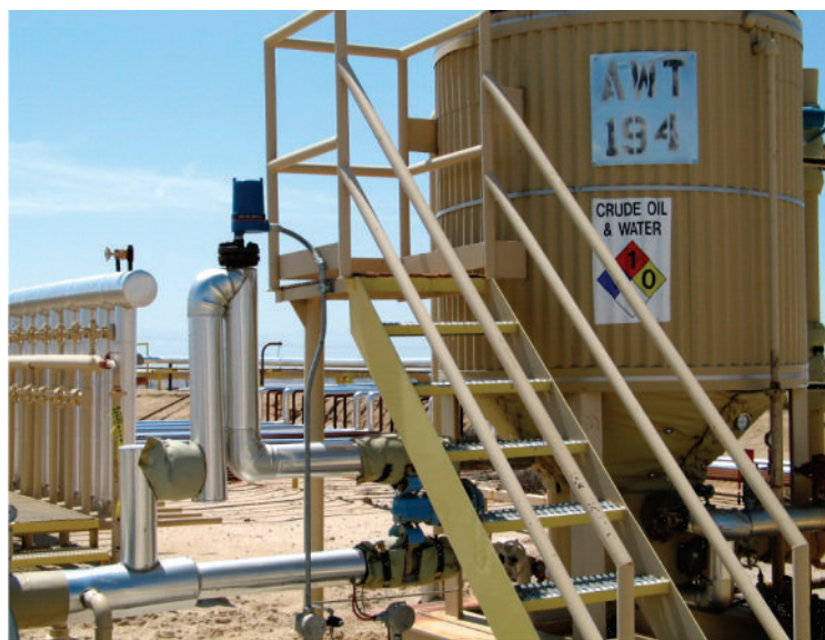
Aplicação de medição de água em óleo usando RF Admitância
